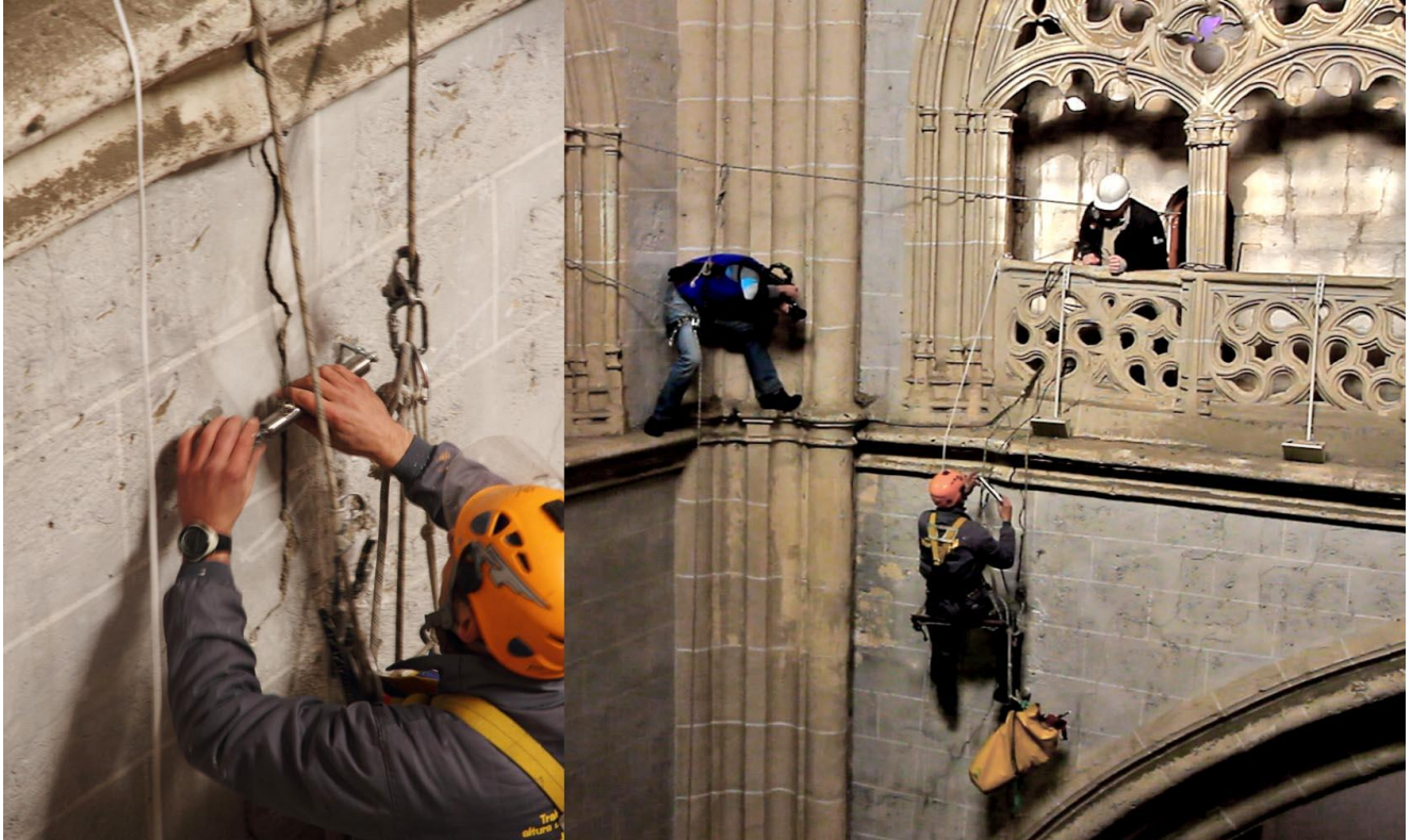
Un especialista durante la colocación de un fisurómetro para detectar movimientos en la estructura de la Catedral de Palencia.
